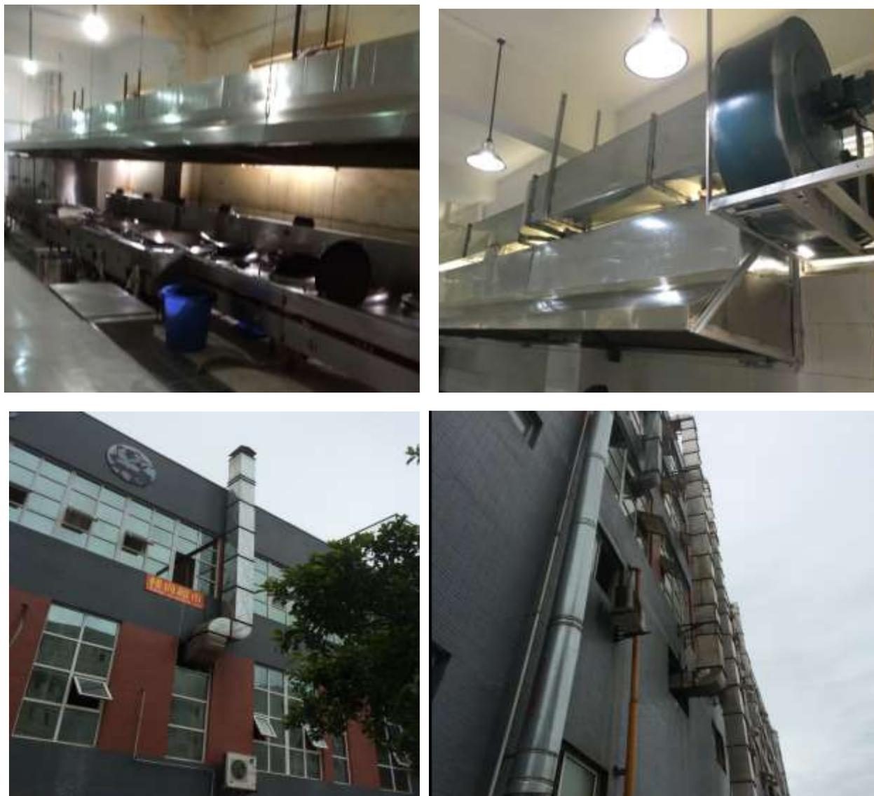
图 3-3 食堂油烟净化器及排放管道图
